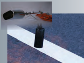
Auftragung mit einem Brenner
