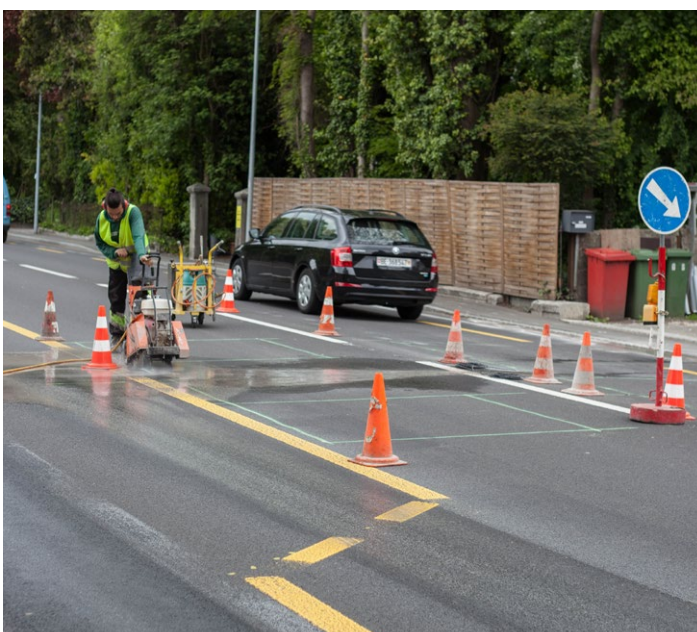
Installatie van lussen volgens MetroCount specificaties.
