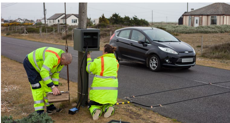
Slangtellers zijn eenvoudig te installeren en te verplaatsen.
