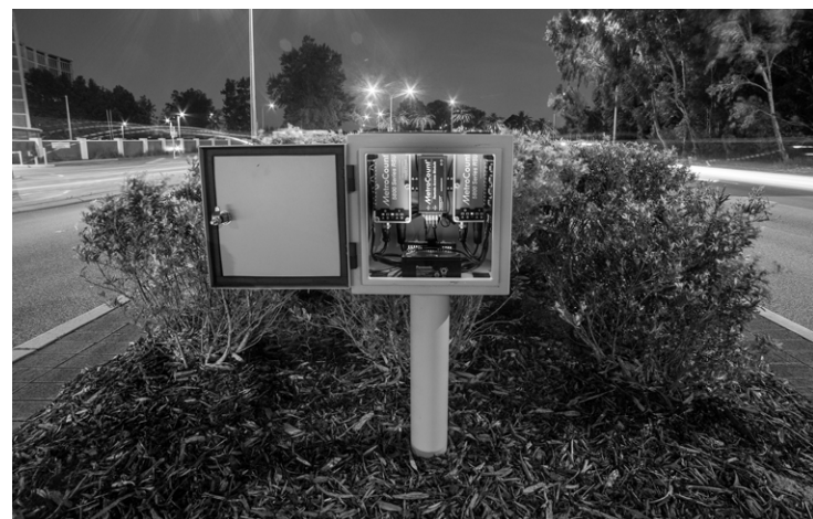
Teller, schakelbord en 3G-modem in kast.
