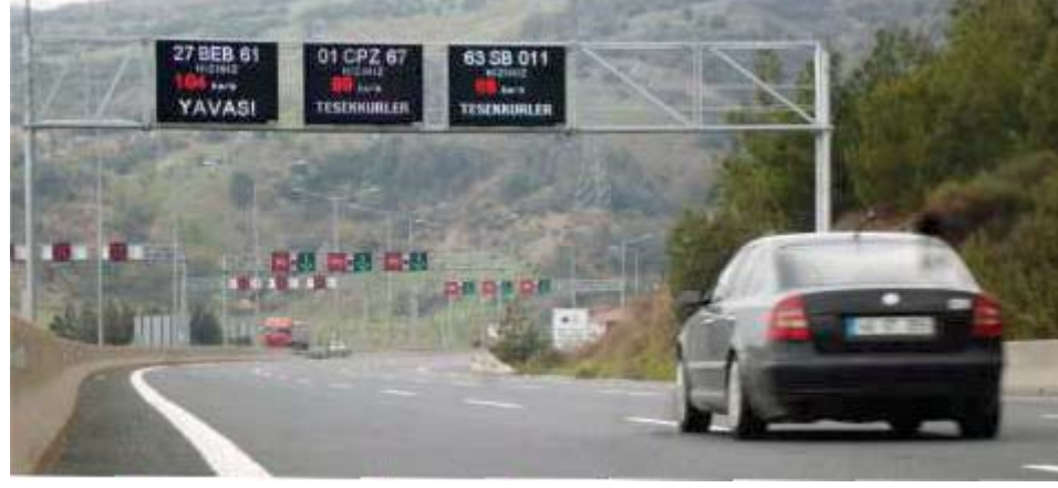
RADOR 201, Taşoluk, Ayran, Kızlaç ,Aslanlı Tunnels, ADANA / 2014 RADOR 201, Taşoluk, Ayran, Kızlaç Ve Aslanlı Tünelleri, ADANA
