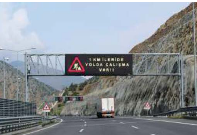
Pozanti Eminlik Tunnels ITS, ADANA / 2010 Pozanti Eminlik Tünelleri ITS Projesi, ADANA
